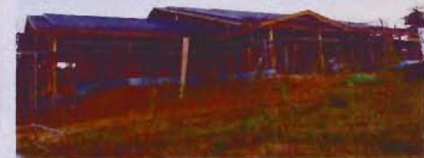
屋根がかかった第2グループホーム
